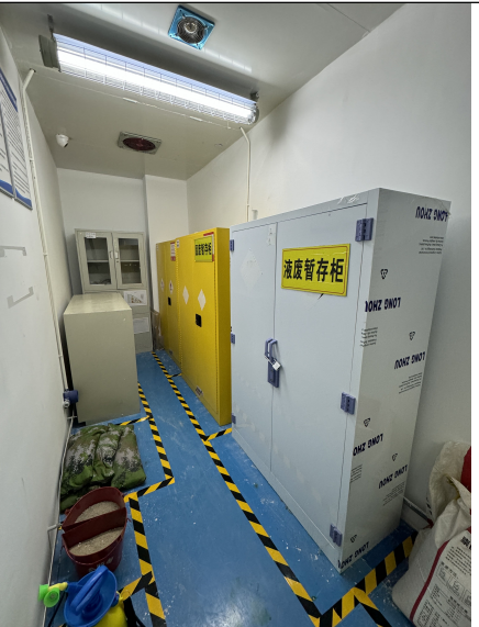
危废暂存间（标志标识、分区存放、制度张贴）
